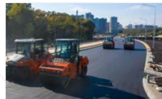
Строительство автомобильной дороги от ул. Шишкова до ул. Тимирязева, г. Воронеж
