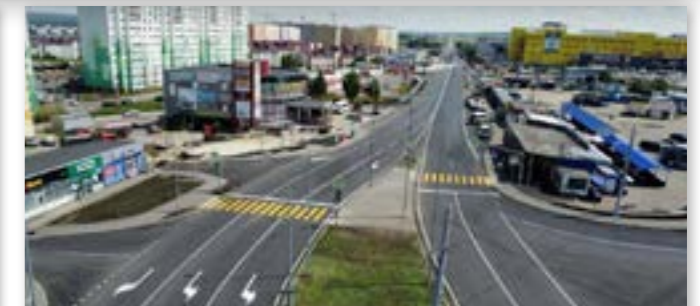
Реконструкция автомобильной дороги г. Пенза – р.п. Шемышейка – с. Лопатино, г. Пенза
