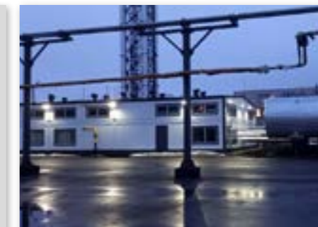
Модульная котельная, г.о. Жигулевск, Самарская область
