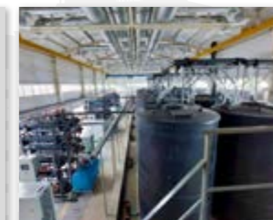
Реконструкция Южной водопроводной станции №2, г. Калининград
