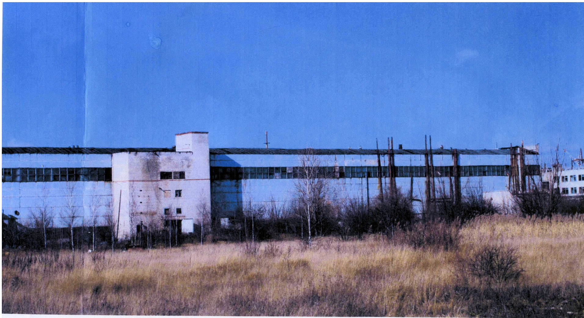
Восточный фасад корпуса 3-120 в осях 10 – 20. Длина по фасаду 216 м
