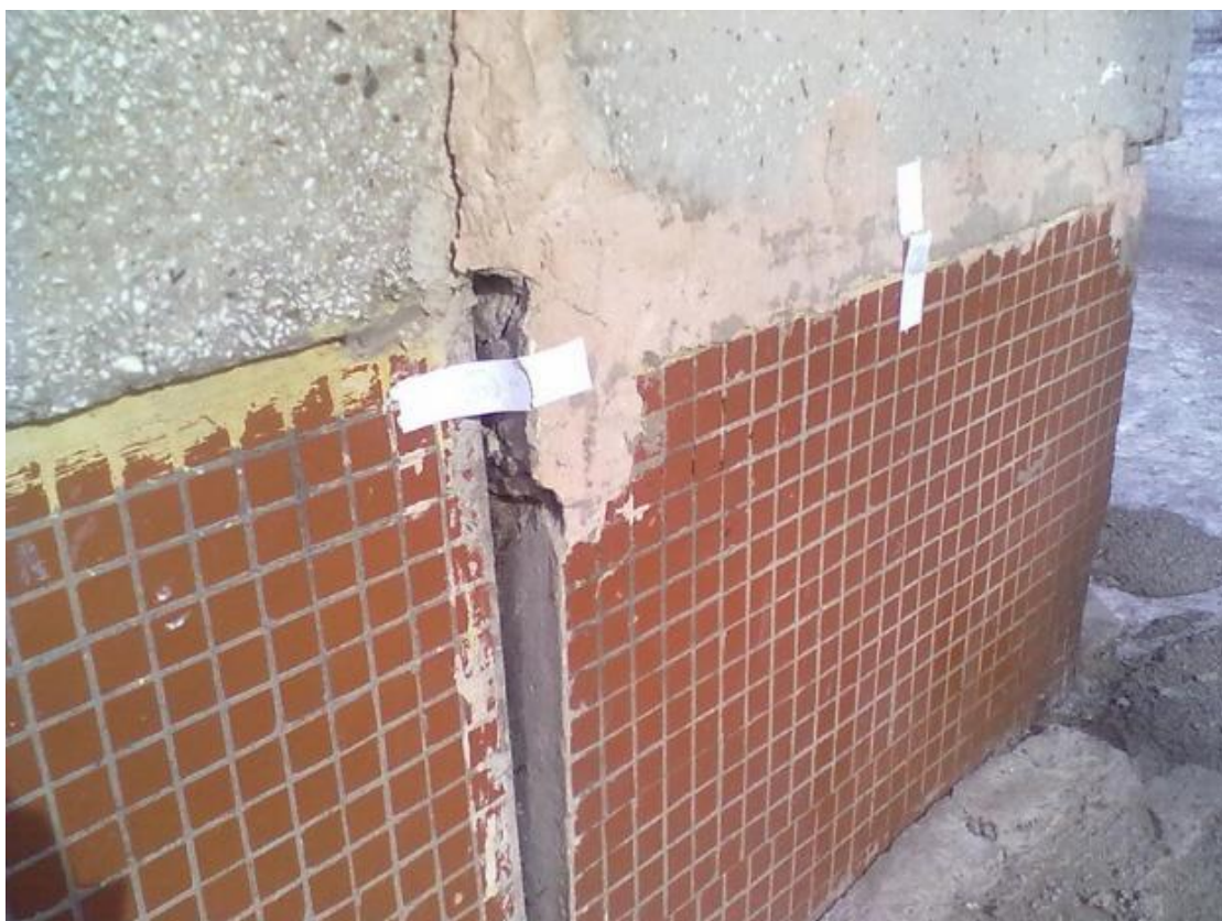
Рисунок 7.40 – Смещение стеновой панели из плоскости стены.
