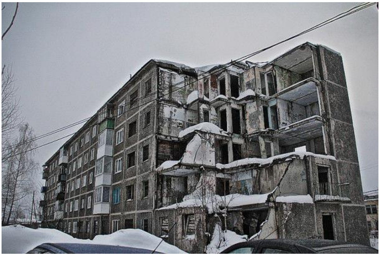
Рисунок 7.2 – Физическое отсутствие наружных и внутренних простенков.
